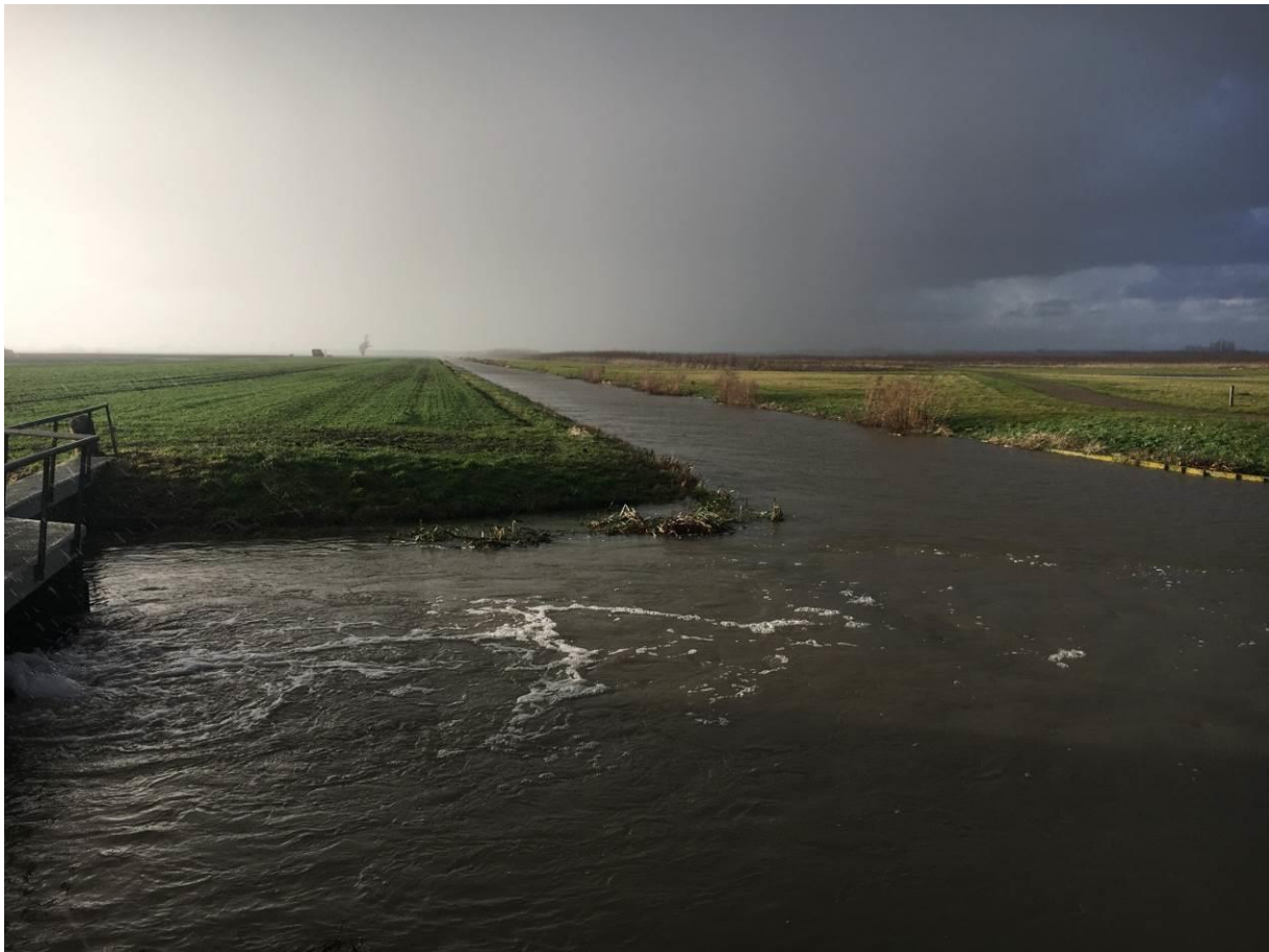
Figuur 5-5: Uitstroom vakgemaal Van der Torre in de Machinetocht
