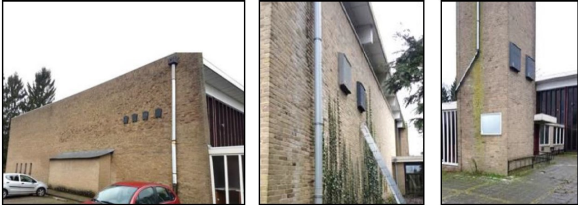
Figuur 3. Locaties tijdelijke vleermuiskasten: 4 verblijfkasten zuidgevel voormalig kerk (links); 2 verblijfkasten noordgevel voormalige kerk (midden); 2 verblijfplaatsen noordzijde kerktoren (rechts).
