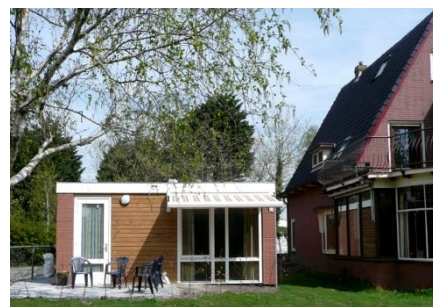
Figuur 2: mantelzorgwoning, foto Platform 31
