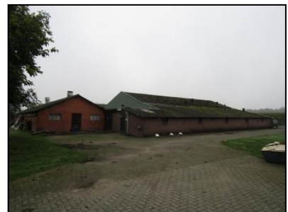
Figuur 5. Westelijk gelegen varkensstallen.
