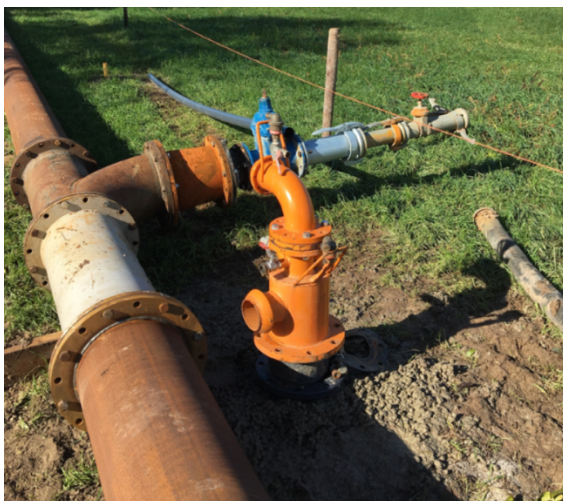
Afbeelding 6: Retourbron naast afvoerleiding. Infiltratie 10-15 m -maaiveld.
