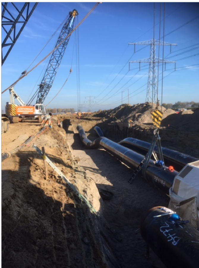
Afbeelding 4: Gasunie legt de drie gastransportleidingen als zinker onder de Zevenaarse Wetering aan.
