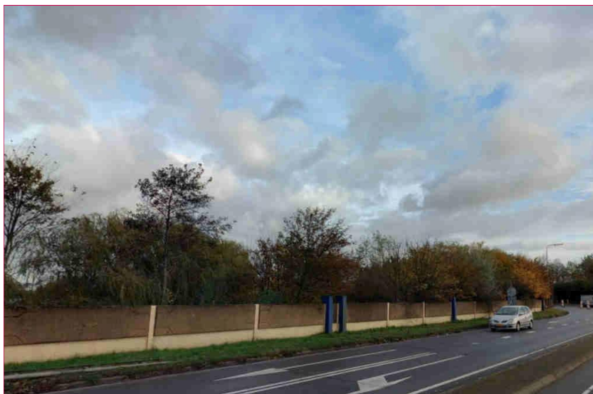
Figuur 3.2: Geluidsafscherming Woudseweg (foto: Cyclomedia)
