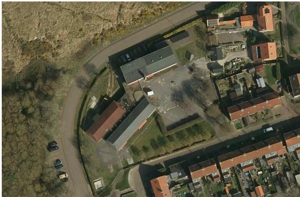
Figuur 1.1. Nieuwbouwlocatie met het oude schoolgebouw
