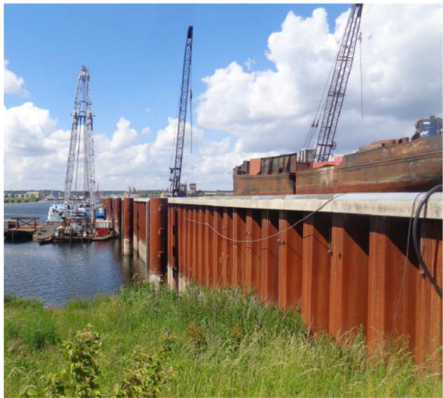
Figuur 3.10 Damwand op projectlocatie met betonnen deksloof
