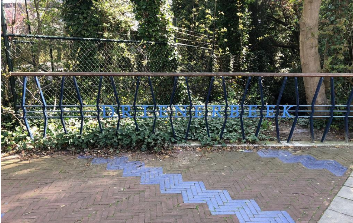
Figuur 15: Te handhaven hekwerk Paul Krugerstraat
