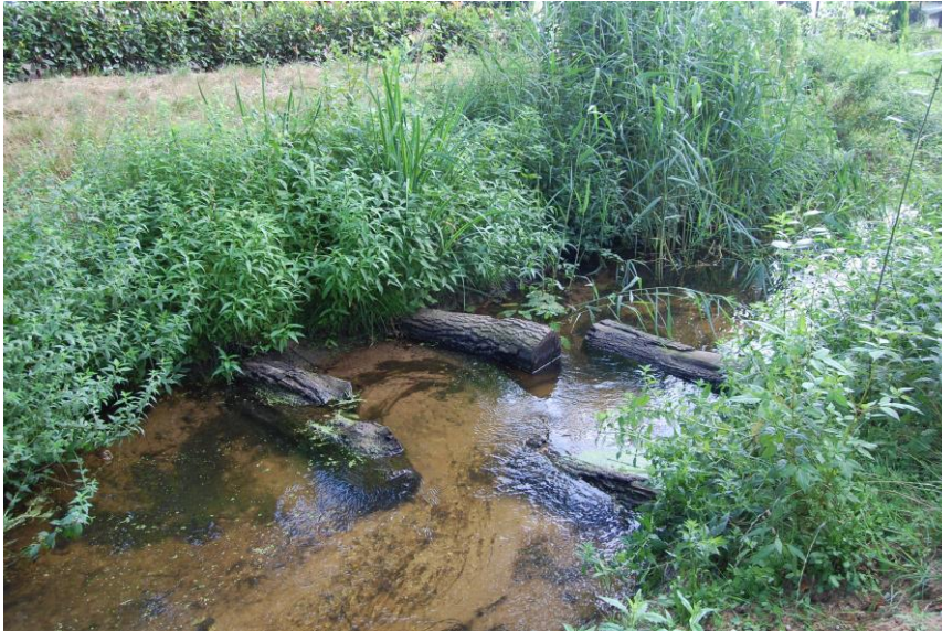
Figuur 11. Voorbeeld van een houtconstructie
