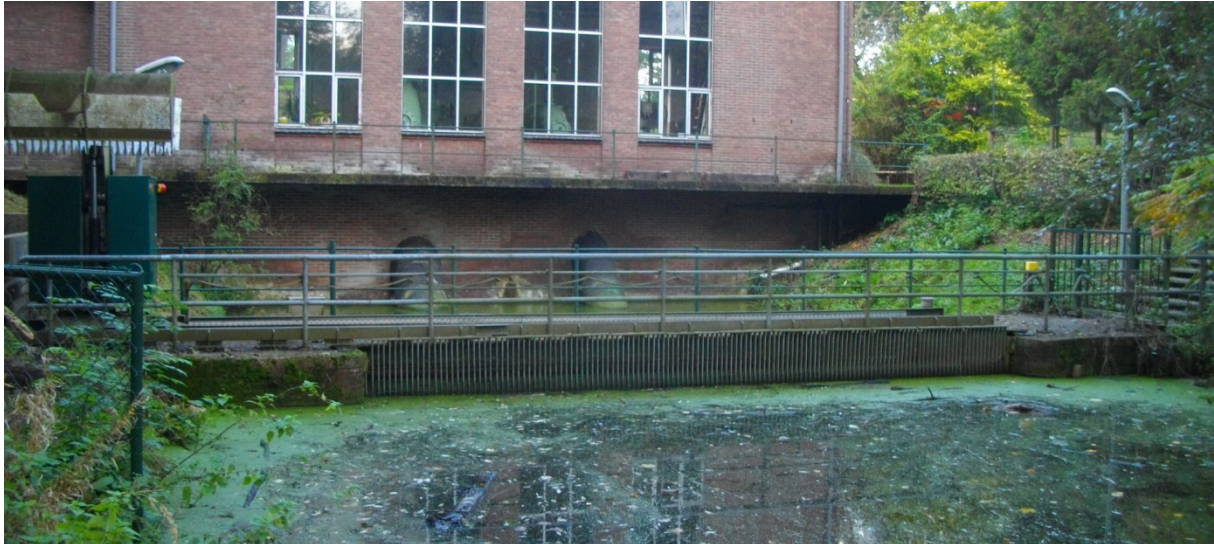
Figuur 4.6 Het krooshek van gemaal Schipholdijk met aan de linker kant de automatische krooshekreiniger
