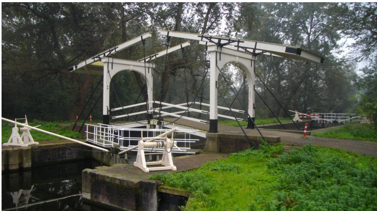
Figuur 3.9 De sluis van de Nieuwe Meer naar Bosbaan (Amsterdamse Bos)
