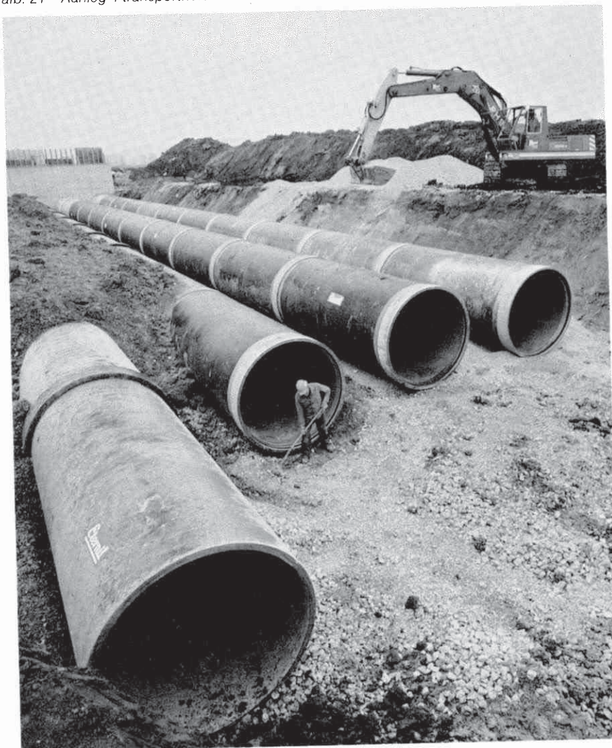
afb. 21 Aanleg 4 transportriolen \varnothing 2000 \text{ mm}
