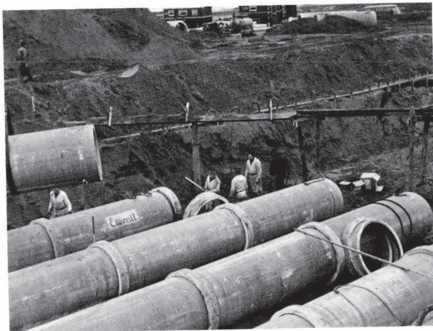
afb. 23 Aanleg 4 transportriolen \varnothing 1400 mm
