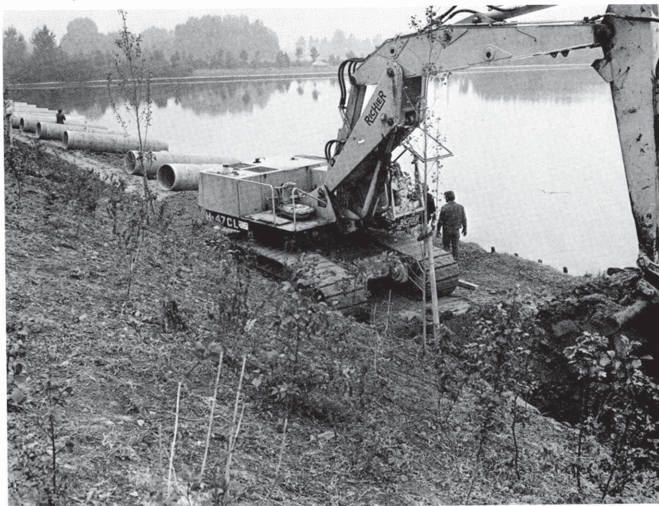
afb. 29 Aanleg Ø 800 mm waterleiding
