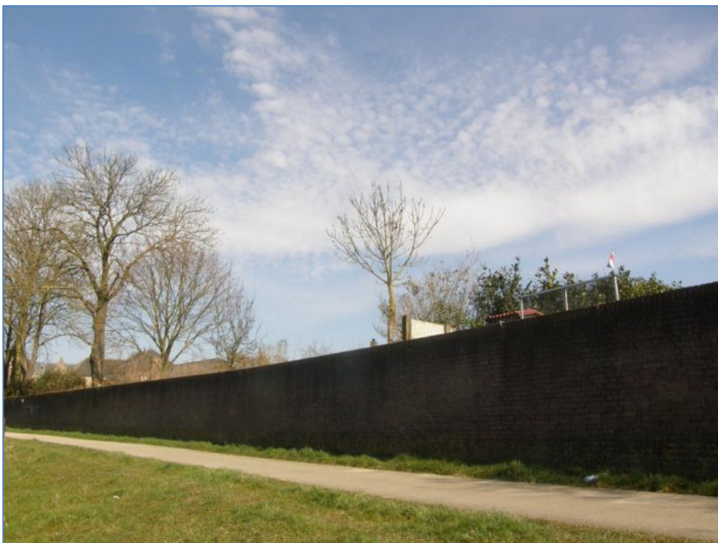
Figuur 3.9: Dijklichaam ter hoogte van 54l t/m m, volledig uitgevoerd als stenen kering. Vlak achter – en soms ook voor- de kering staan vaak bomen en struiken
