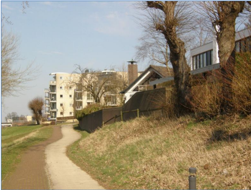
Figuur 3.8: Dijklichaam ter hoogte van 54i t/m k, waar de “groene kering” vanuit het noorden overgaat in een stenen kering
