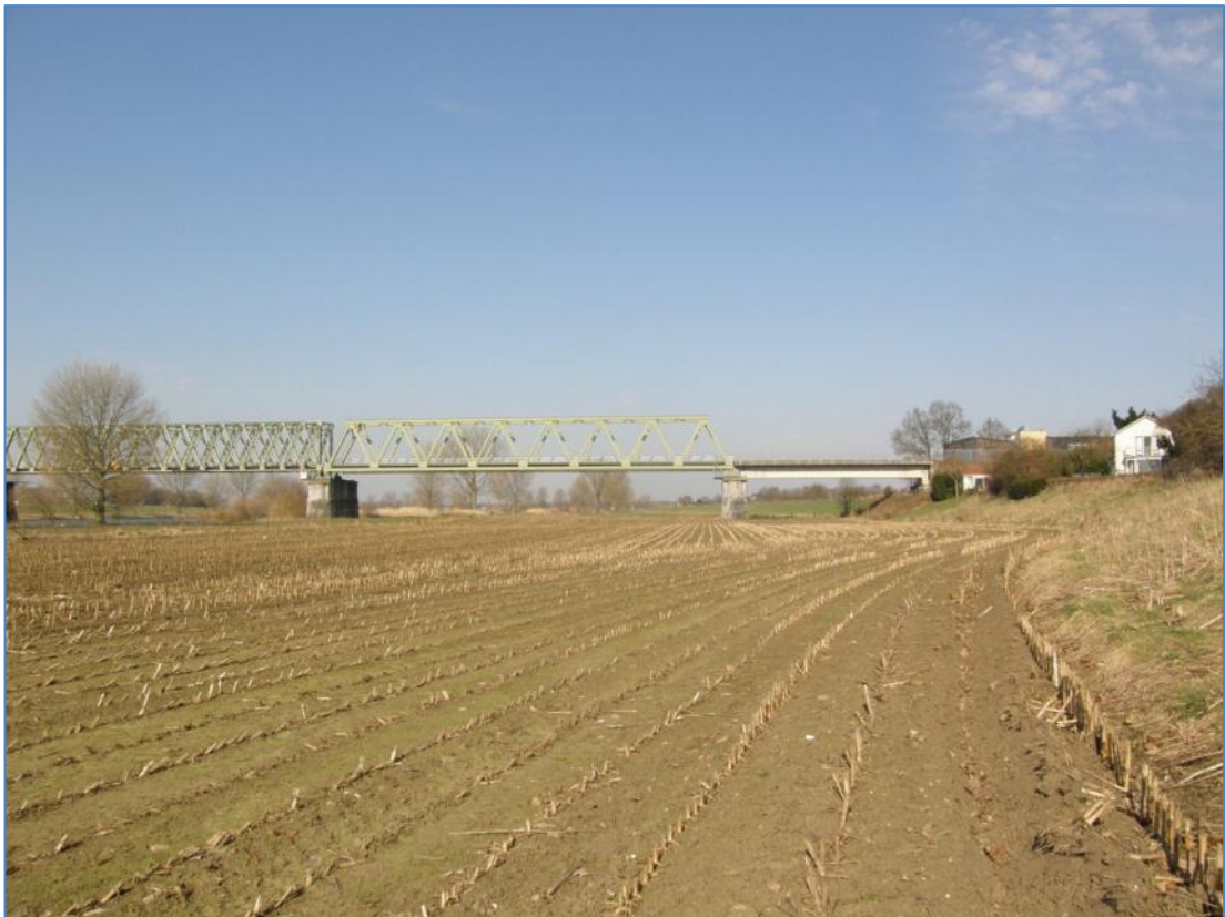
Figuur 3.7: Dijklichaam ter hoogte van 54p, vlakbij de spoorbrug van de lijn Venlo-Nijmegen. Hier geeft de kade een ruig beeld en is het terrein tot op de teen van de dijk in agrarisch, intensief gebruik. Bovenop de kade zijn particuliere erven met huizen en tuinen aanwezig
