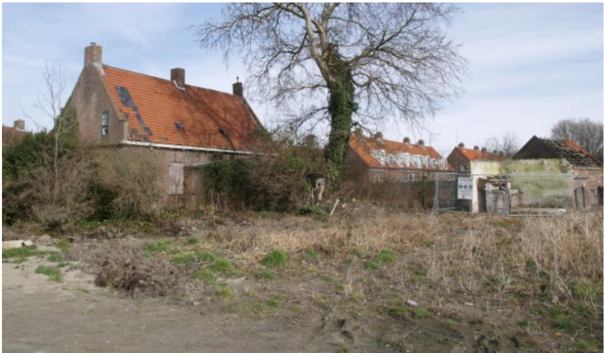
Figuur 35: Gevolgen van sloopwerkzaamheden in het onderzoeksgebied in 2009.
