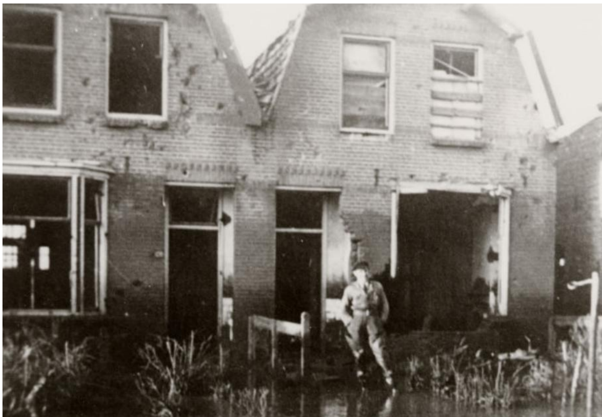
Figuur 17: Een foto uit 1945 van de Vlissingsestraat huisnummers 112 en 114. De woningen hebben schade als gevolg van oorlogsgeweld.
