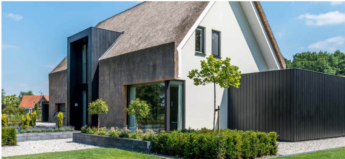
Als toevoeging aan de landelijke stijl kennen de woningen een bouwkundig element met modern materiaalgebruik (bijvoorbeeld kaders als accenten in wit of zwart) die een mooi contrast vormt
