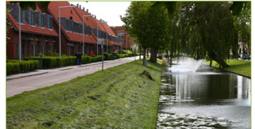
De taluds zijn veranderlijk van steil tot flauw, wat het natuurlijke karakter onderschrijft
