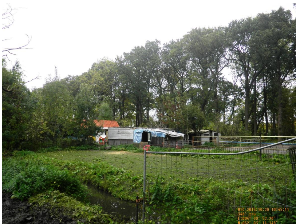
Foto 5: Het stenen gebouw en een aantal schuren
