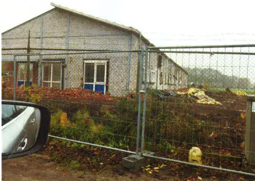
Fig. 4. Foto van de loods van omstreeks 15 nov met gesloopte buitenschil.
