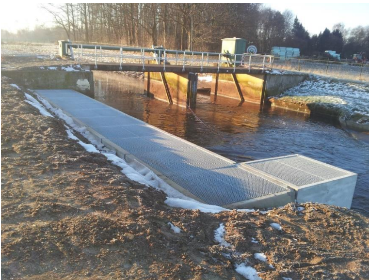
Figuur 5. Referentiefoto van een De Wit-vispassage langs een stuw, in dit geval in de Aa bij Veghel (bron: waterschap Aa en Maas)
