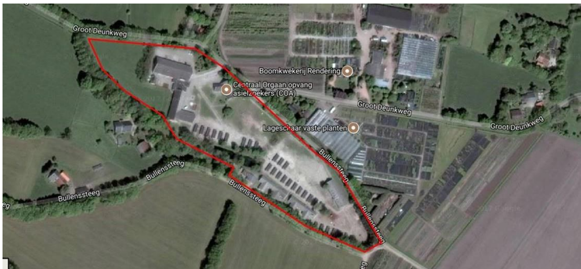
Afb.1. Luchtfoto van het projectgebied (binnen het rode kader). (uit Projectplan Wnb AZC-terrein Groot Deunkweg 5 Aalten, Gras advies, 2018)
