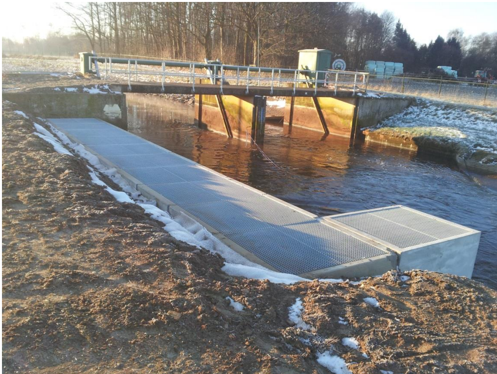
Figuur 4. Referentiefoto van een De Wit-vispassage langs een stuw, in dit geval in de Aa bij Veghel (bron: waterschap Aa en Maas)
