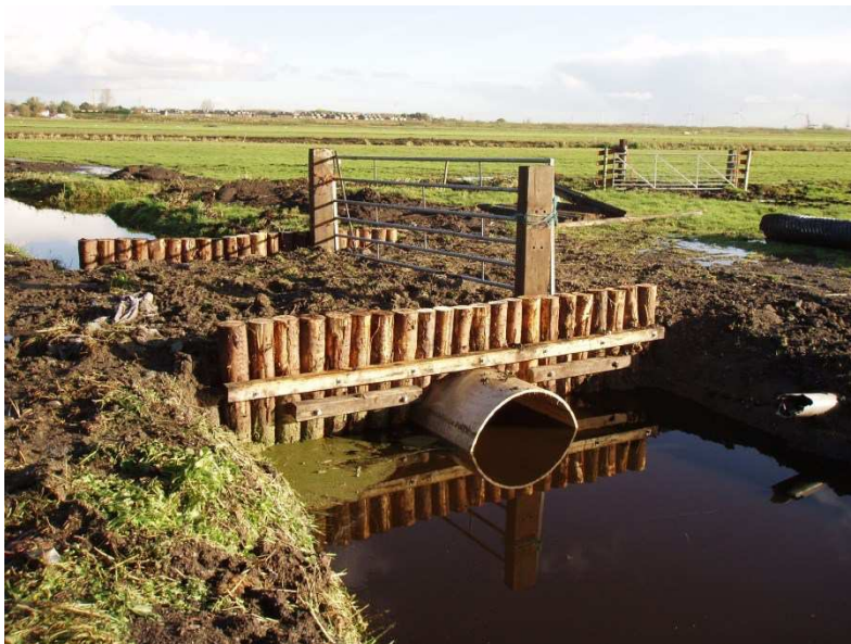
Figuur 3-2: Voorbeeld van een Lariks palenrij met dubbele eiken klemgording
