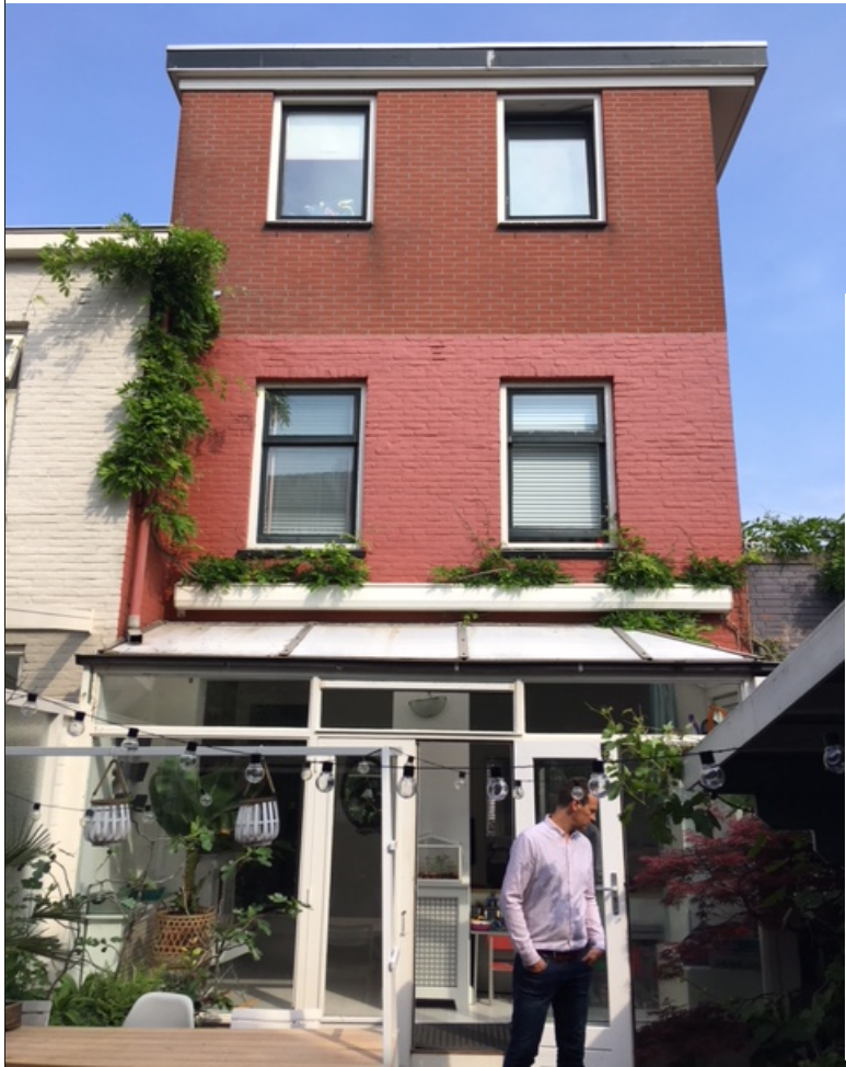
ACHTERGEVEL MET BESTAANDE SERRE/AANBOUW
