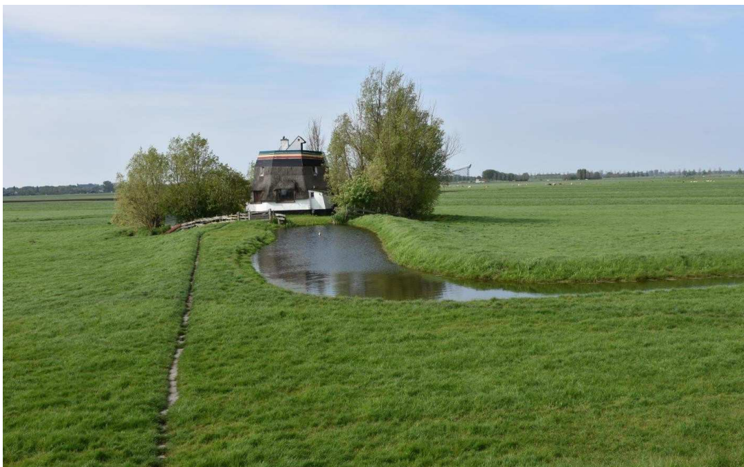
Figuur 4.16. Hoogwatervoorziening WW-15HW01, tevens inlaat.
