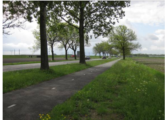
Wegberm langs fietspad
