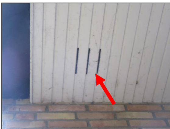
Foto 7: Opening aan de onderzijde van het dak
