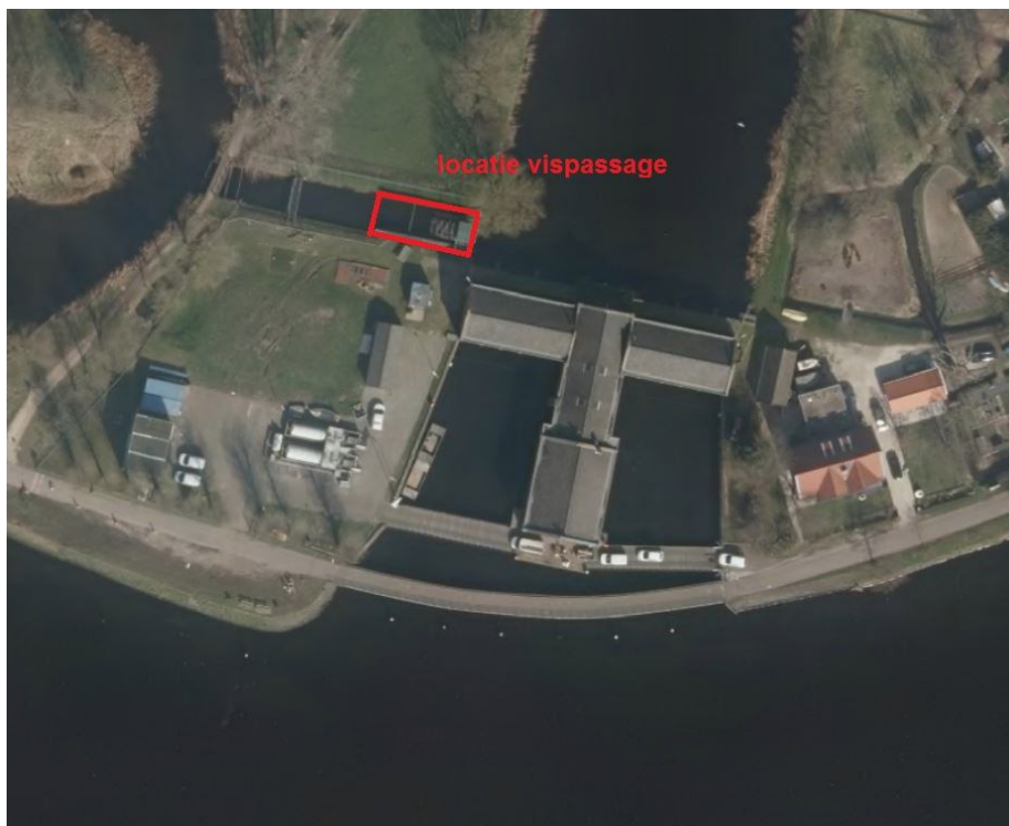
Figuur 2: Overzichtsfoto locatie vispassage (Bron: Geoweb).
