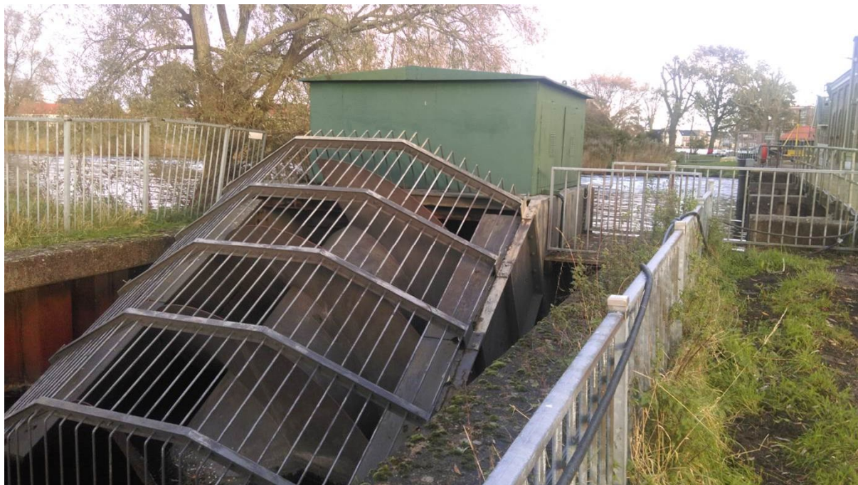
Figuur 3: Foto d.d. 6 nov. 2017, genomen bij het huidige noodvijzelgemaal.
