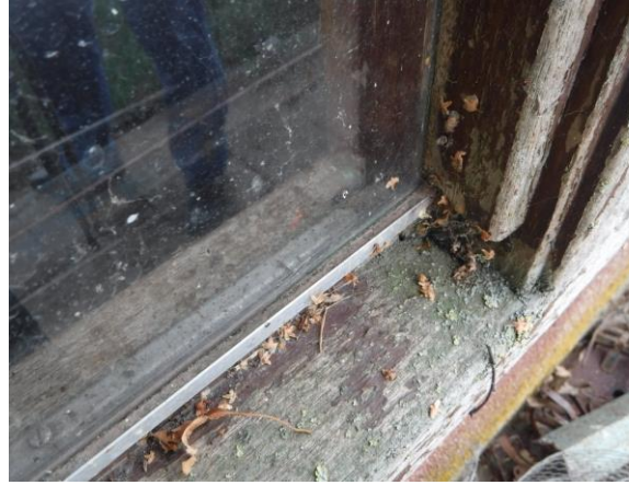
niet asbestverdachte kit kozijn garage
