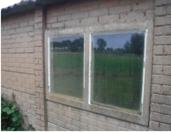
niet asbestverdachte stopverf schuur
