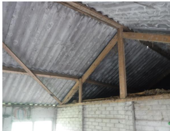
binnenzijde dakconstructie schuur 1
