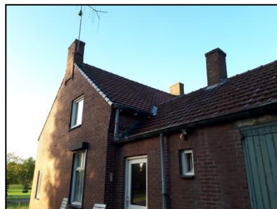
Figuur 4. Detailopname van de oostzijde van de woning
