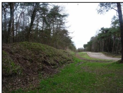
Figuur 7. Noordzijde van de zuidelijk gelegen geluidswal.
