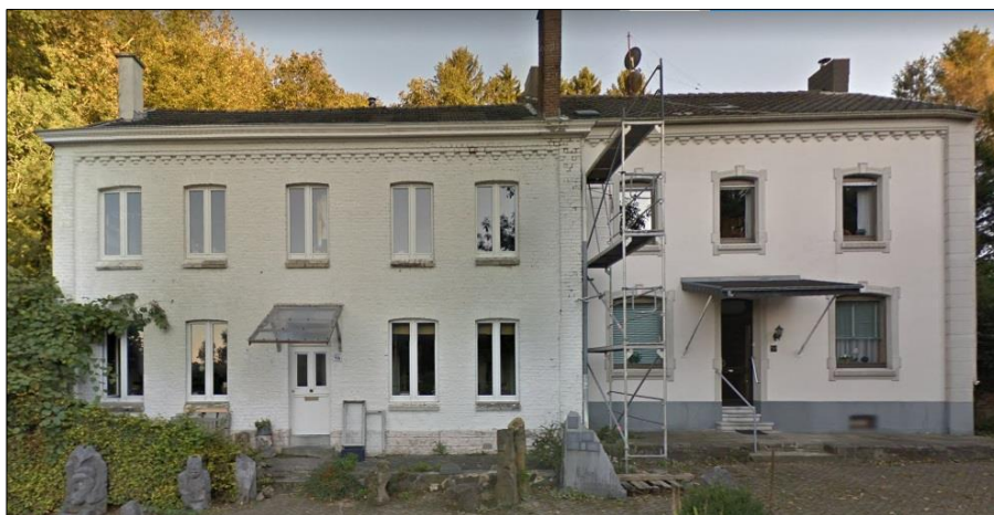
Foto bestaande situatie Gemmenicherweg 56 (links) en 58 (rechts)
