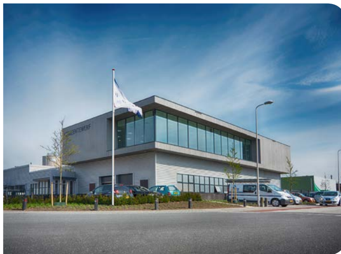
Vernieuwde gemeentewerf in Rijssen; duurzaam gebouwd, energieneutraal en hoge ruimtelijke kwaliteit
