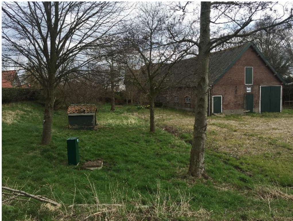
Figuur 1 De schuur is gelegen aan de Wilsveen 28 te Leidschendam en is opgetrokken uit gemetselde muren en een pannendak.
