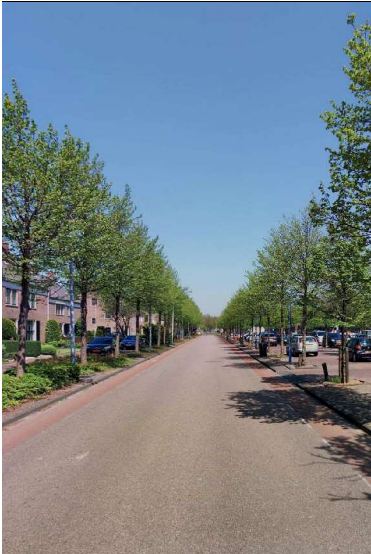
Foto: Terpstraat Wieringerwerf (bron: CycloMedia Technology B.V.)
