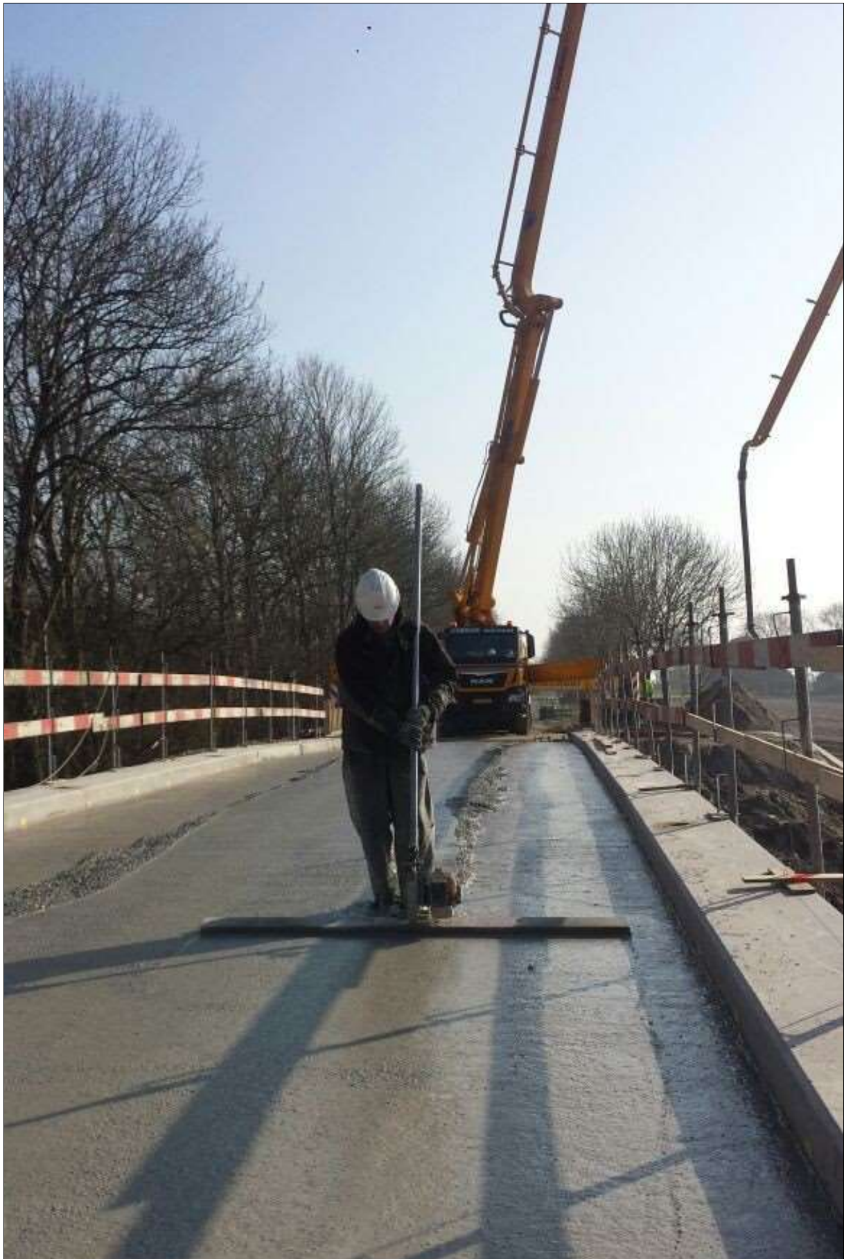
Foto: Uitvoering brugvervanging Kolhornerweg (bron: Gemeente Hollands Kroon)
