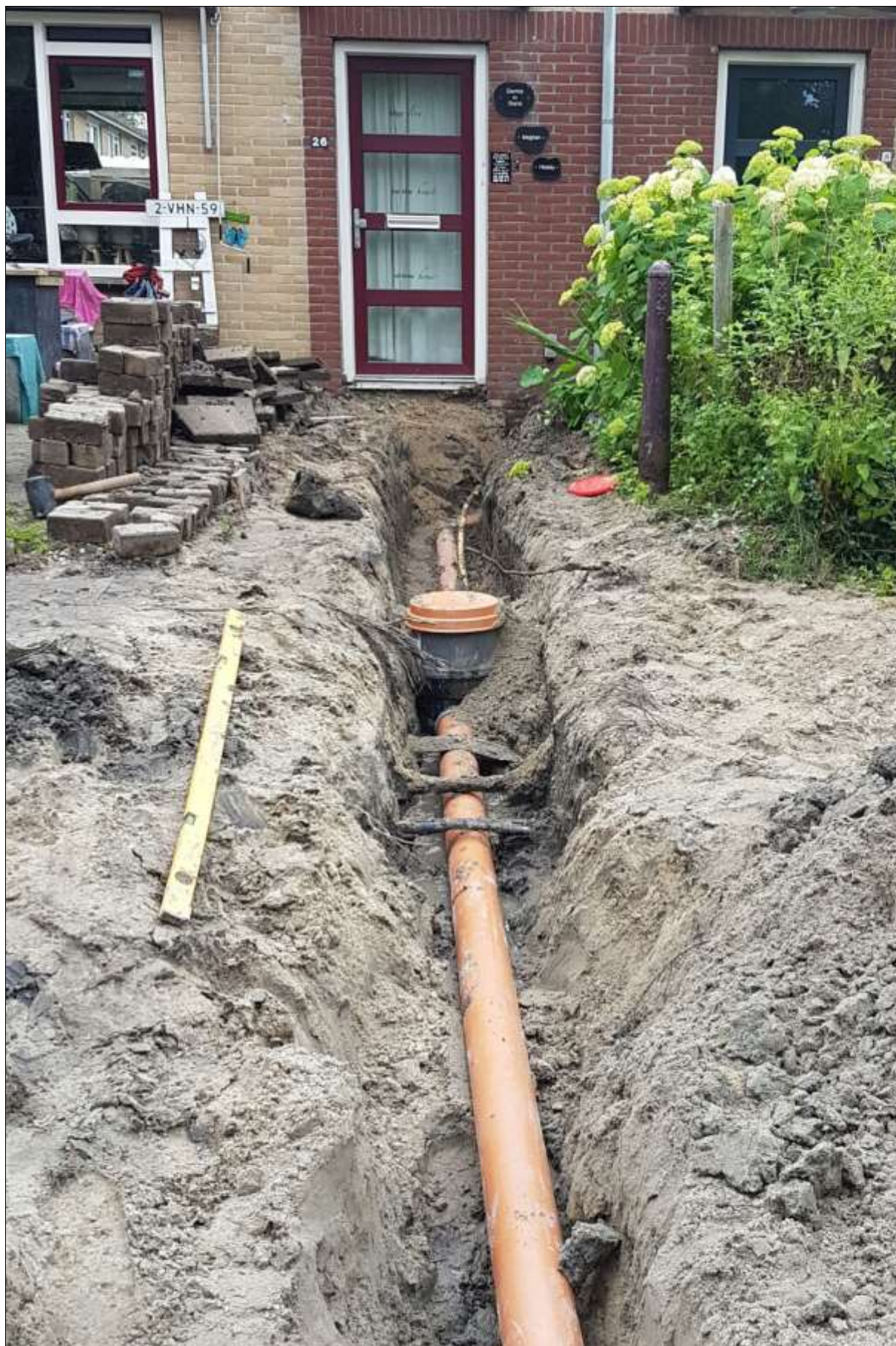
Foto: Rioolvervanging in de Populierenlaan in Wieringerwaard (bron: Gemeente Hollands Kroon)
