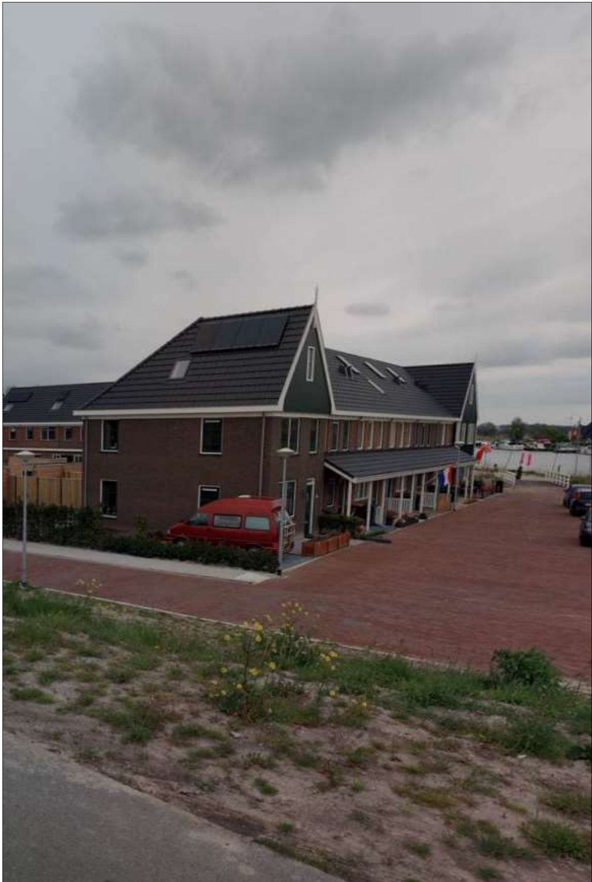
Foto: Nieuwbouw Ansjoviskade Kolhorn (bron: CycloMedia Technology B.V.)
