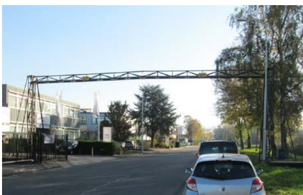
Brug over de weg ten behoeve van transportleiding onttrokken water naar zuivering én transportleiding van zuivering naar lozingspunt
