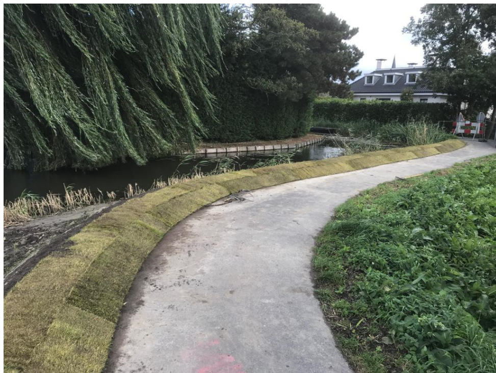
Figuur 2 Vervangende waterkering Kluisgade noord
