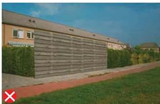
niet passend door afwijkende hoogte
