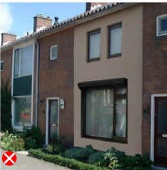
niet passend door afwijkend materiaal- en kleurgebruik
