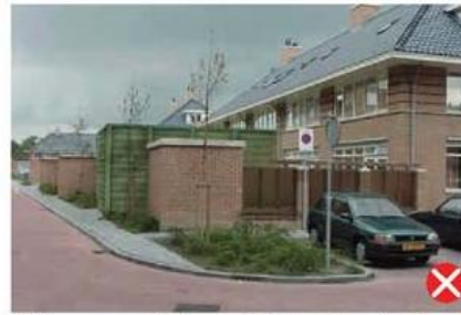
niet passend door afwijkend materiaal- en kleurgebruik
