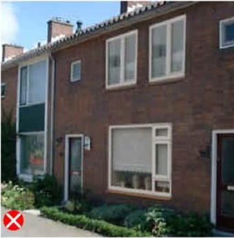
niet passend door afwijkende indeling
