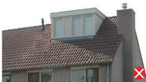
niet passend door plaatsing
