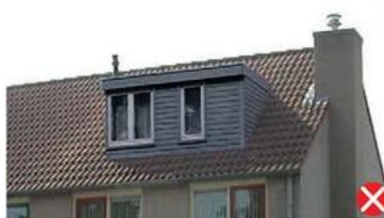
niet passend door afwijkend materiaal- en kleurgebruik
