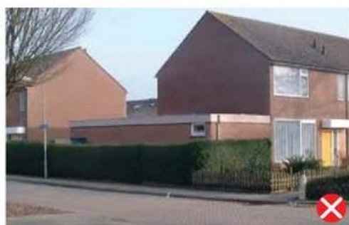
niet passend door plaatsing in rooilijn
