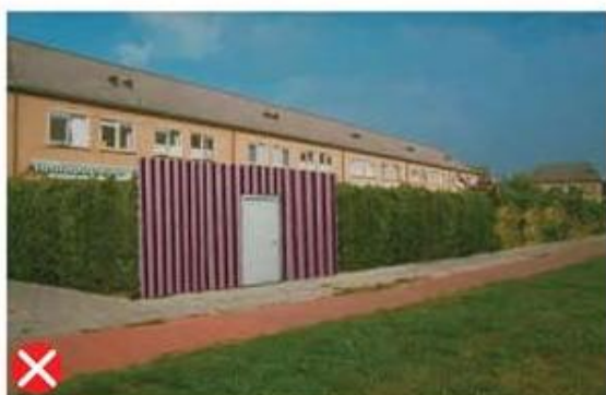
niet passend door gebruik damwand-profiel
