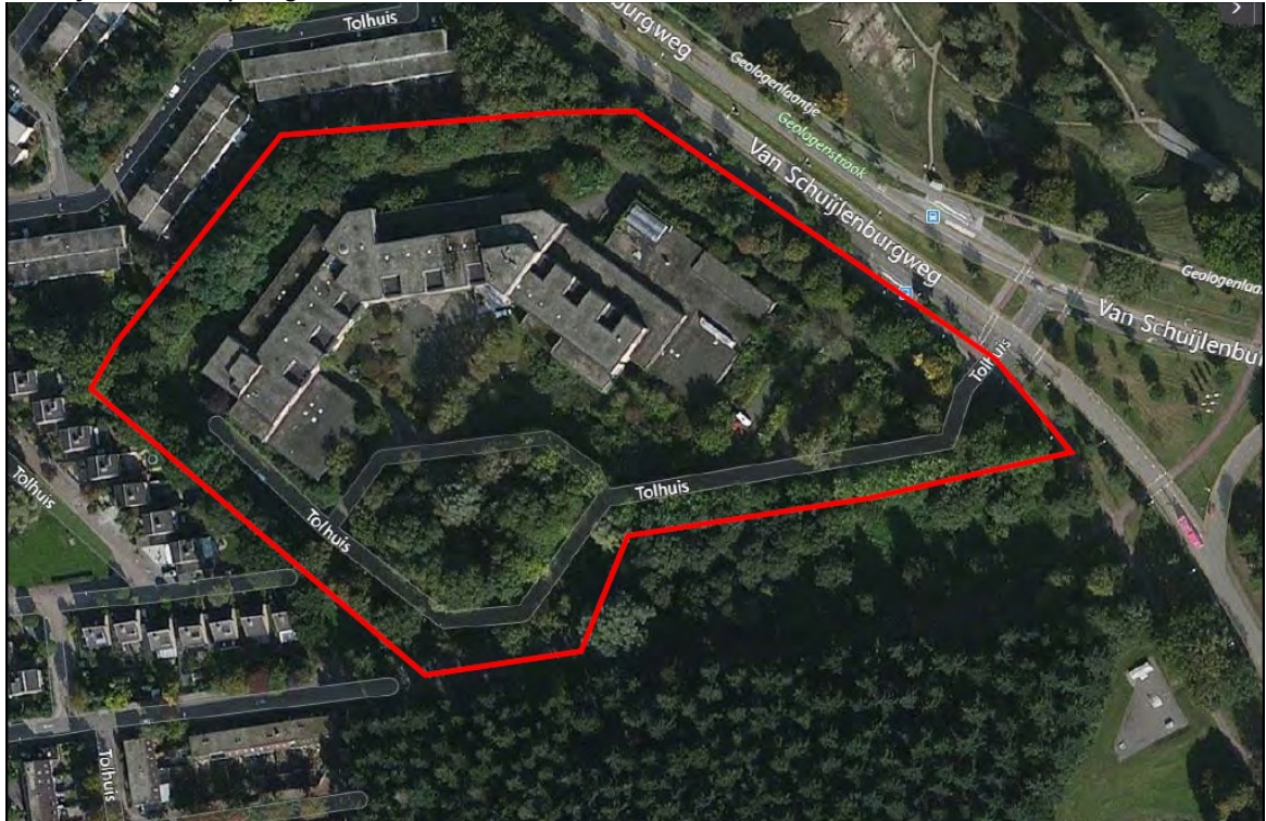
Figuur 2: Gedetailleerde ligging van het te slopen schoolgebouw aan de Schuylenburgweg 3 te Nijmegen-Dukenburg, met het schoolgebouw aan de noordzijde en de houtopstanden aan de zuidzijde van het plangebied.
