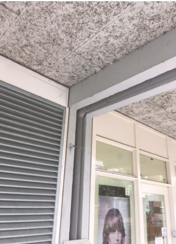
HWA's en betonconsole's accentueren 5.1 stramien.
