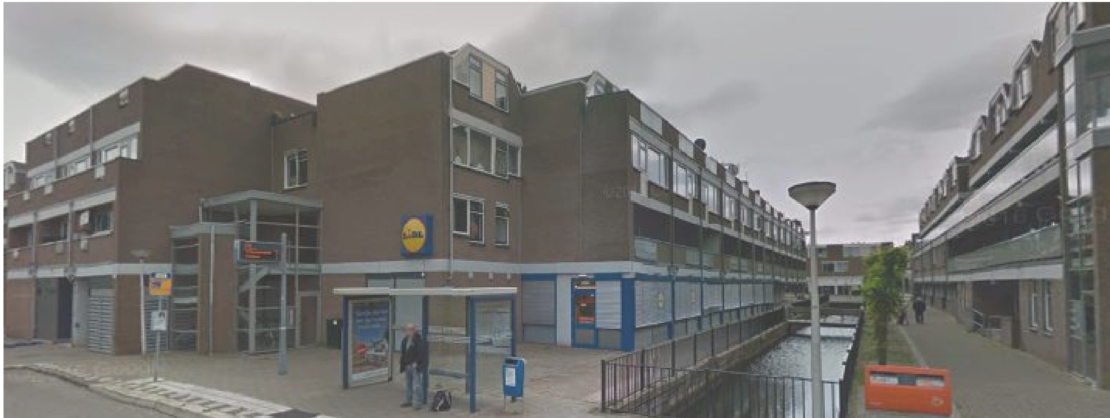
Gevel aan waterzijde. Overstek door Lidl dichtgezet middels ( blauwe ) winkelpuien.
