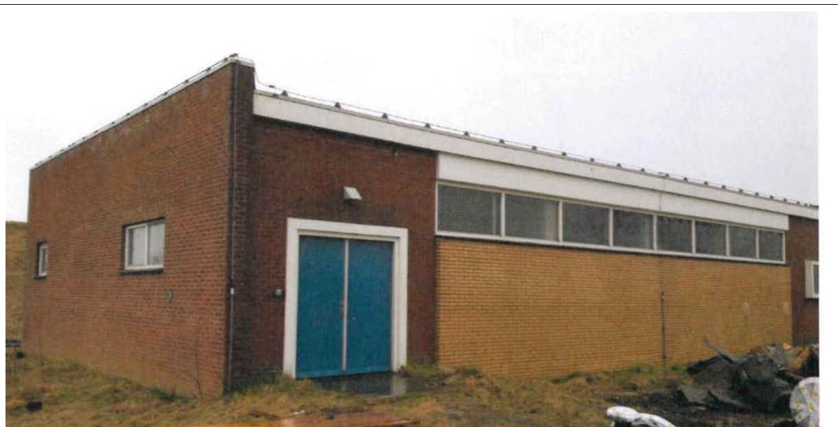
Figuur 4. Bestaande situatie (foto april 2018, Bouwconsult 37)
