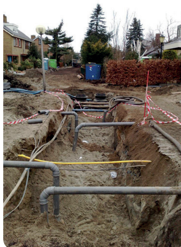
Figuur 0-1: Rioolconstructie met aansluitleidingen in de Melkdistel
