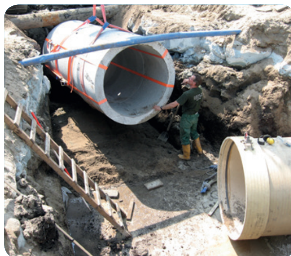
Figuur 2-1: Aanleg Riool in de Eiber en Lijster
