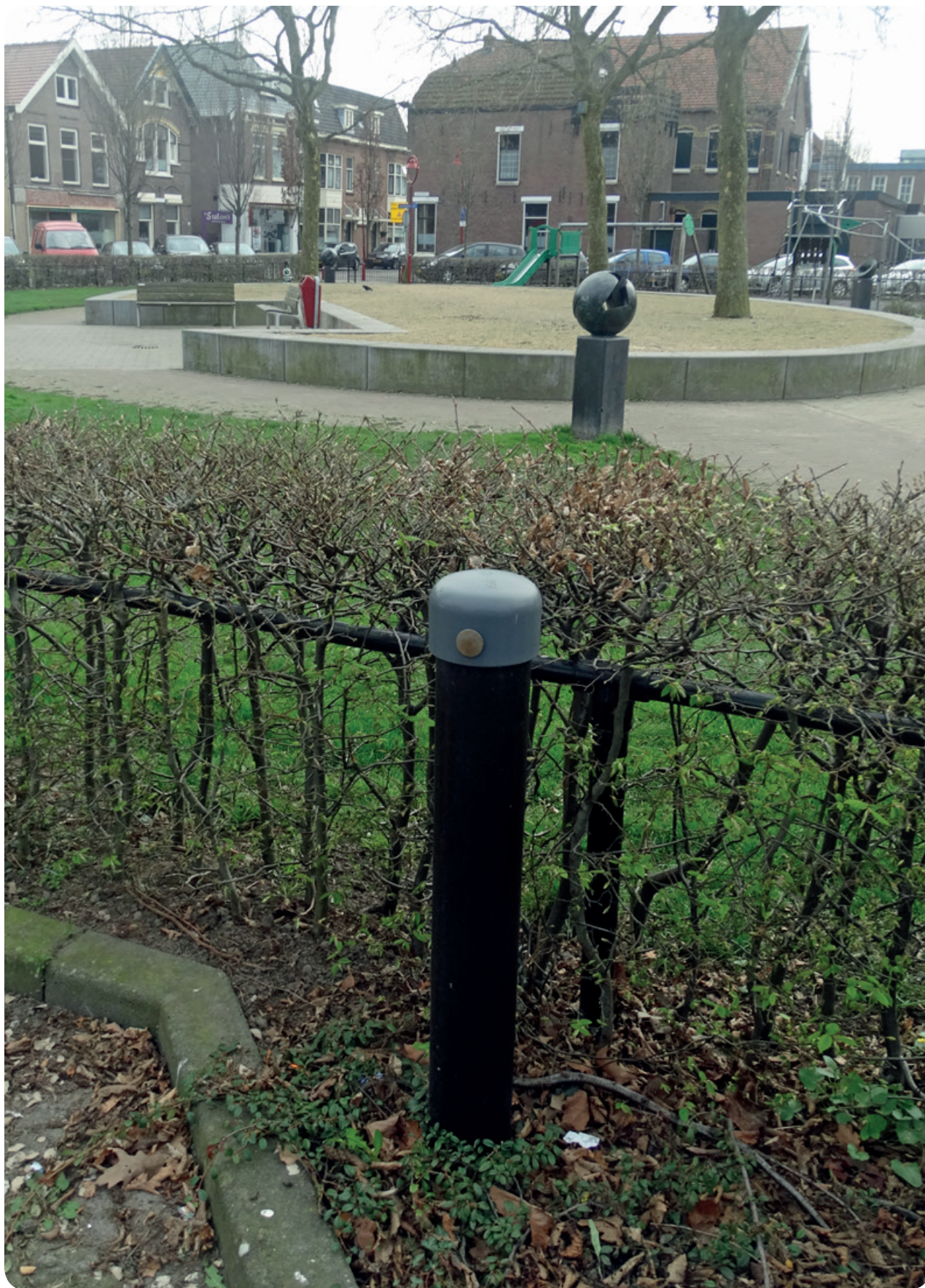
Figuur 5-4: Peilbuis aan de Prins Hendrikstraat
