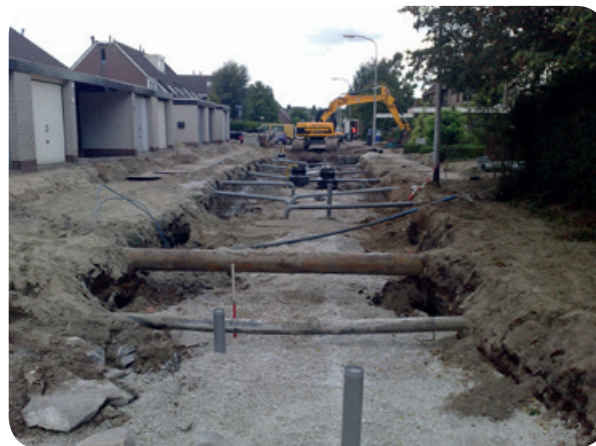
Figuur 5-2: Rioolreconstructie in de Wederik
