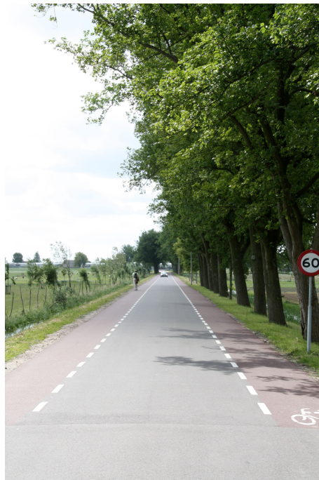
Figuur 2.20: Erftoegangsweg buiten bebouwde kom type 1 (60 km/h)
