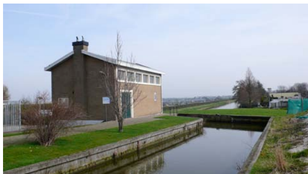
Berkel en Rodenrijs - gemaal aan de Noordeindseweg
