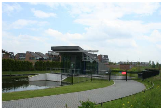
Het gemaal Meerpolder (2010) bij de Kruising Meerweg/Klapwijkseweg.
