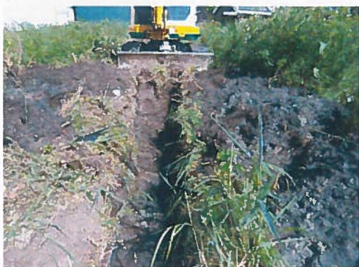
Foto 7 opname van sleuf 3
