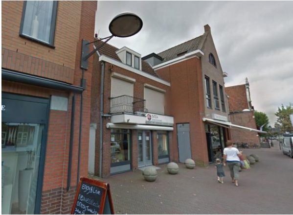
Figuur 2.4 Huidige situatie Dorpsstraat (bron: google maps)
