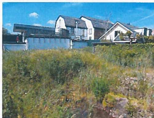
Foto 2 zicht op ontgraving in terrein
