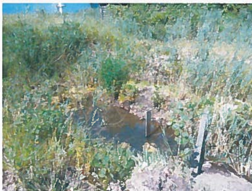
Foto 1 zicht op ontgraving in terrein
