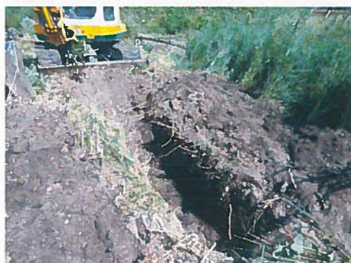
Foto 8 opname van sleuf 4
