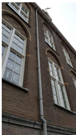
Linker deel, dilatatie voorgevel (1958)
