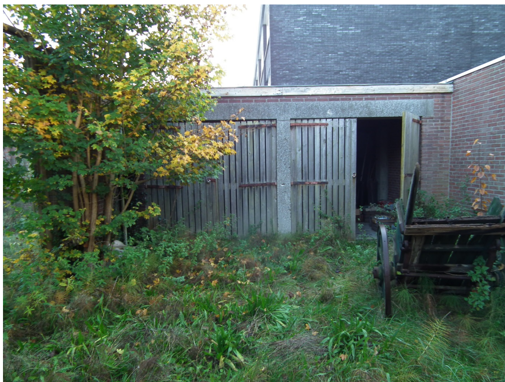
Figuur 3 Op de planlocatie staat ook een schuur met houten toegangsdeuren. De schuur is in gebruik als opslaglocatie.
