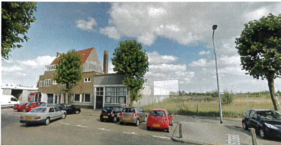
Figuur 3, gesloopte bebouwing Van Dishoeckstraat 540/542 (Bron: google maps)
