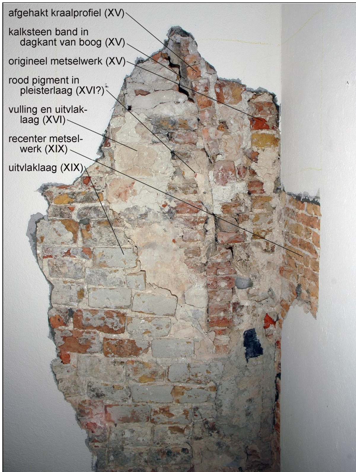
[9] Rechter dagkant van de spitsboog in de opkamer met analyse van bouwsporen, 2009. Een Romeins cijfer geeft de eeuw aan waarin een onderdeel gedateerd wordt.
