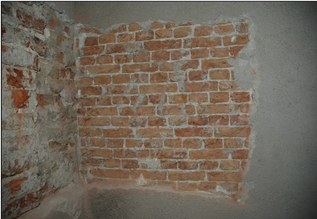
[4] Op de bogenmuur sluit aan de zuidkant van fietsenstalling/washuisje 19de-eeuws werk aan, 2009
