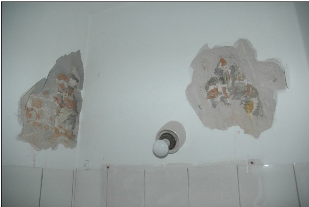
[5] De voormuur van het huisje (zijde fietsenstalling, links) en de oostelijke zijmuur (met de bogen), 2014. Het linker kijkvak brengt een bouwnaadje aan het licht. De zijmuur bleek, na vergroten van het rechter kijkvak, middeleeuws metselwerk te bevatten.
