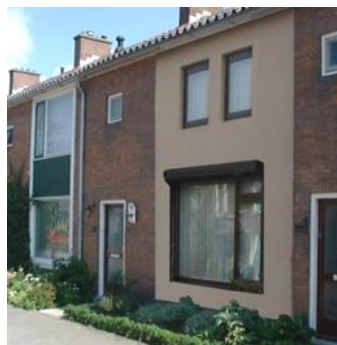
Niet passend door afwijkend materiaal- en kleurgebruik
