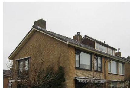
Dakopbouw door een nokverhoging gericht naar de achterkant. Door de donkere en gedekte kleur van de zijwangen komt de dakopbouw minder nadrukkelijk over op het dakvlak.
