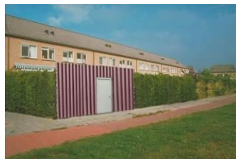
Niet passend door afwijkend materiaal- en kleurgebruik
