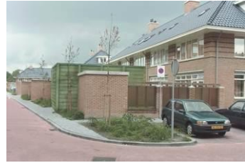
Niet passend door omvang, materiaal- en kleurgebruik.
