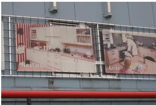
De screenreclame is onvoldoende afgestemd op de gevel
