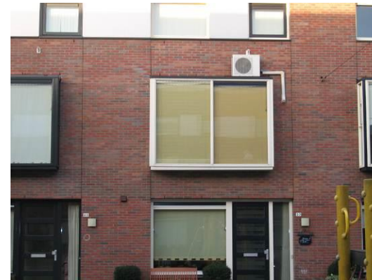
Een airco-installatie heeft veelal een ingrijpende en ongewenste invloed op het gevelbeeld en straatbeeld.
