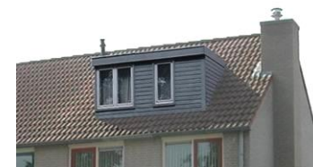
Niet passend door afwijkend materiaal- en kleurgebruik
