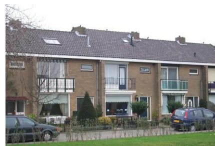
Dakopbouw door een nokverhoging gericht naar de achterkant. Er kan uiteindelijk weer 1 doorgaande noklijn ontstaan.
