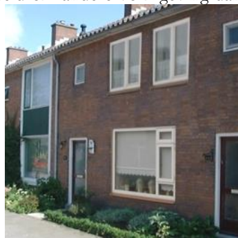
Niet passend door afwijkende indeling
