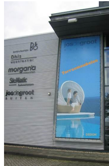
Frame met een meer bouwkundig op het gebouw afgestemd L-profiel.
