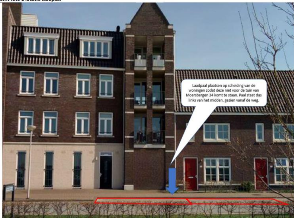
Foto 3 aanzicht foto 1 locatie laadpaal
