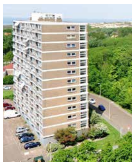
Heliostrooplaan, 1957, hoogte 37m
