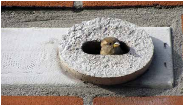
integrale verwerking van nestkast in de gevel
