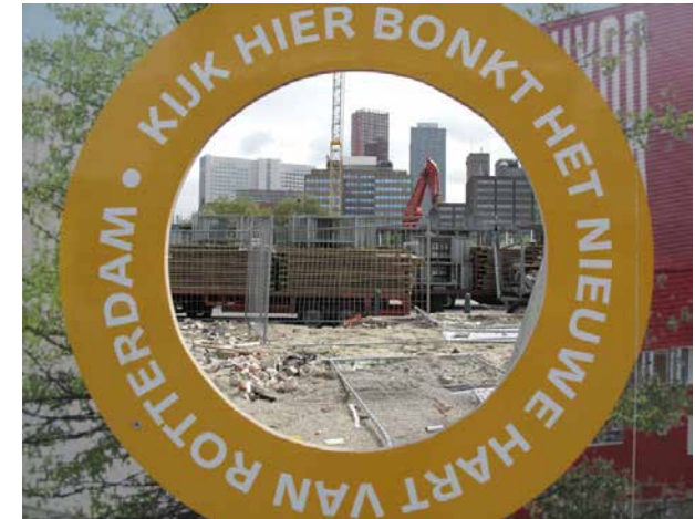
ruimte voor interactie; zichtbaarheid van de bouwplaats
