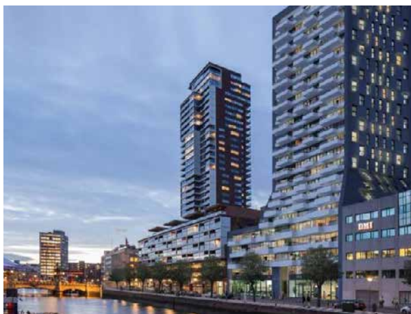
torens op stedelijke laag; Wijnhaven - Rotterdam
