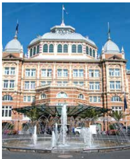
Kurhaus, 1885, huidige hoogte 30m
